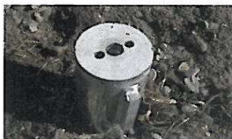
垂直方向 基準高さの+5.00mm、-10.0mm 以内で 施工します。
