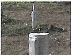
XY 方向 基準位置の±25mm以内で 施工します。
