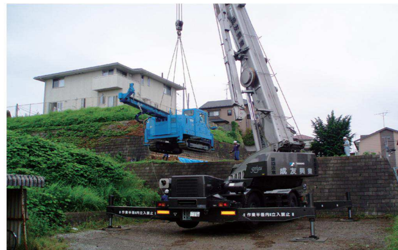
施工機揚重例
