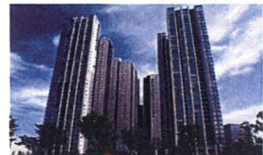
ワールドシティタワーズ(東京都港区、3棟、2,090戸)
