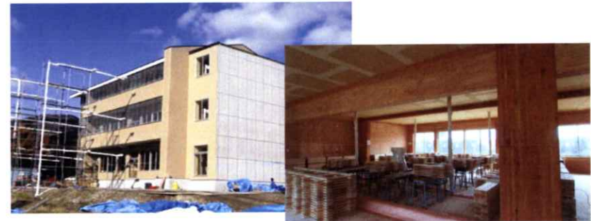
木造の3階建て学校 <実大火災実験の試験体>
