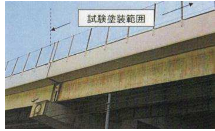
横羽線 大師入路高欄外部試験施工 (比較資料例)
