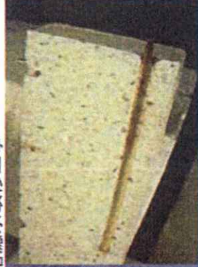
貯水槽減水改修工事
