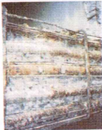
写真-1 シースとPC梁の腐食 (マカオ上水用の山崎建設が完成済みの鉄筋)
