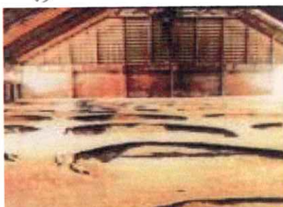
軟弱地盤の不同沈下被害例 (支持杭・RC床構造)
