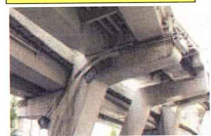
(耐震補強例) ・従来の外部防水型 ・防錆油封入対策等
