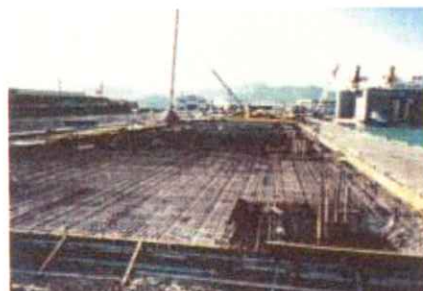
スープロ配筋緊張 PCマット浮き基礎
