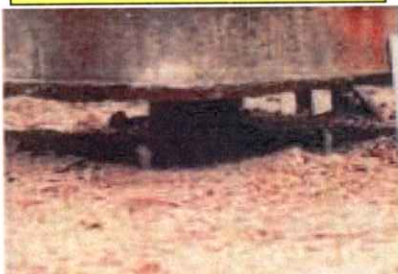
軟弱地盤の不同沈下被害例 (支持杭・RC床構造)
