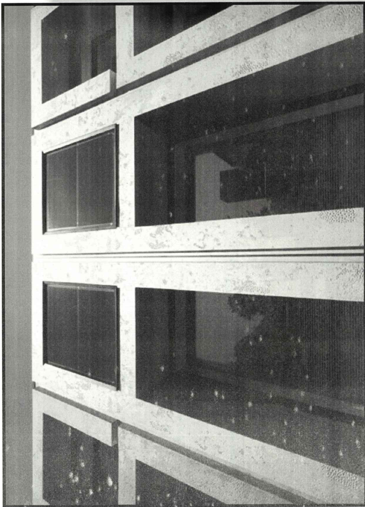
京橋本社ビル外装：上部が太陽光発電パネル兼用部、下部が、いわゆる一般窓部（ビジョン部）で、外壁面から約50cm入り込んで太陽光を軽減する。
