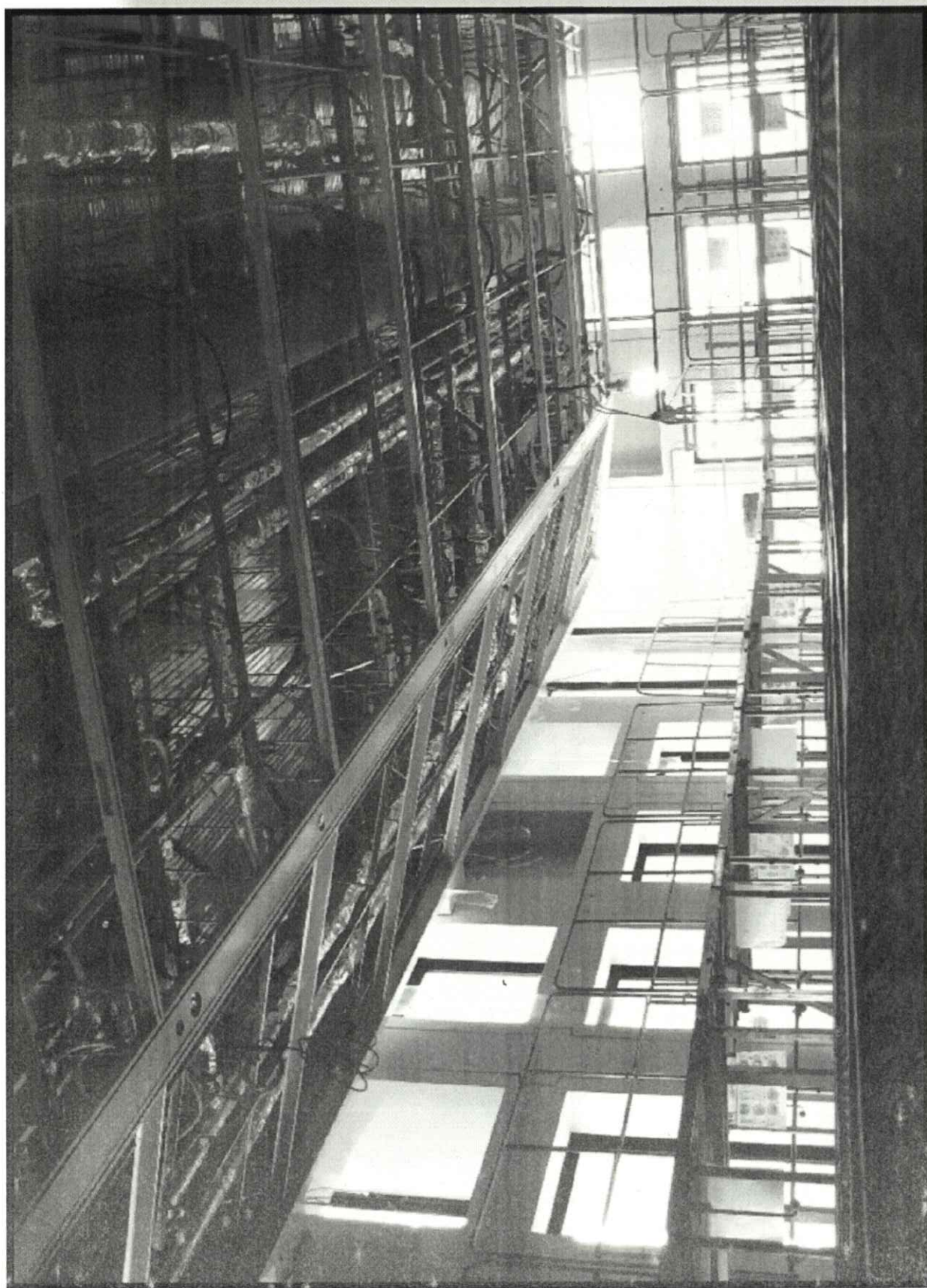
2011年11月22日：オフィス20階天井工事
