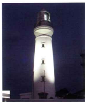
犬吠埼灯台 太陽光発電LEDライトアップ 実証実験
